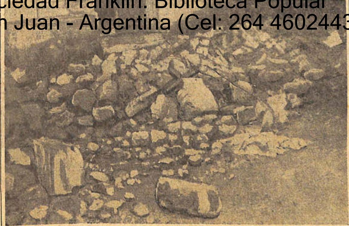
Calle obstruida por los restos de los edificios destruidos por el terremoto
