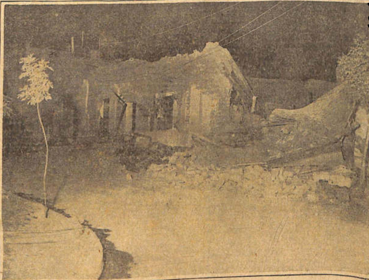
Montón informe de escombros, entre los que aparecen los restos de un automóvil
