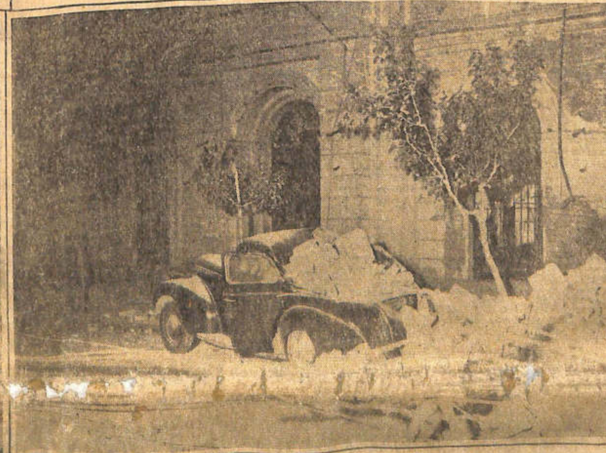
Un automóvil aplastado por desprendimientos del edificio de la Legislatura
