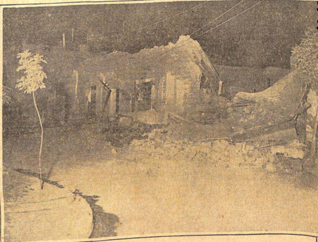
Montón informe de escombros, entre los que aparecen los restos de un automóvil
