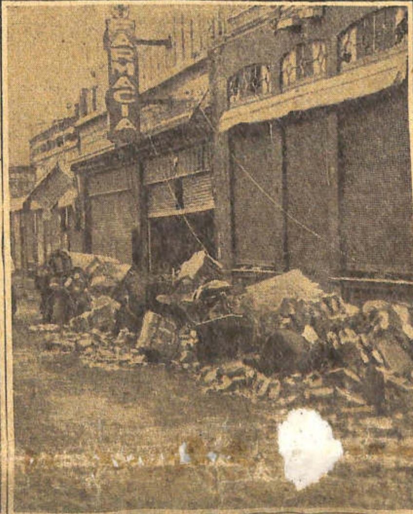
Aspecto de los daños sufridos por una de las calles principales y restos de varios automóviles →
