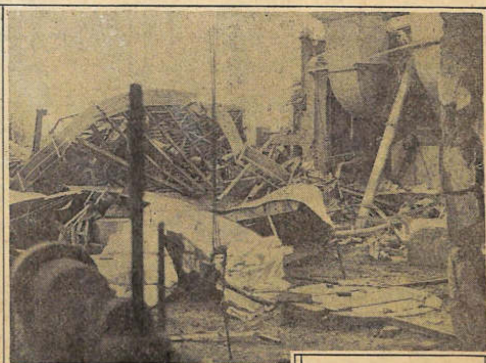
La fábrica de electricidad, después del terremoto
