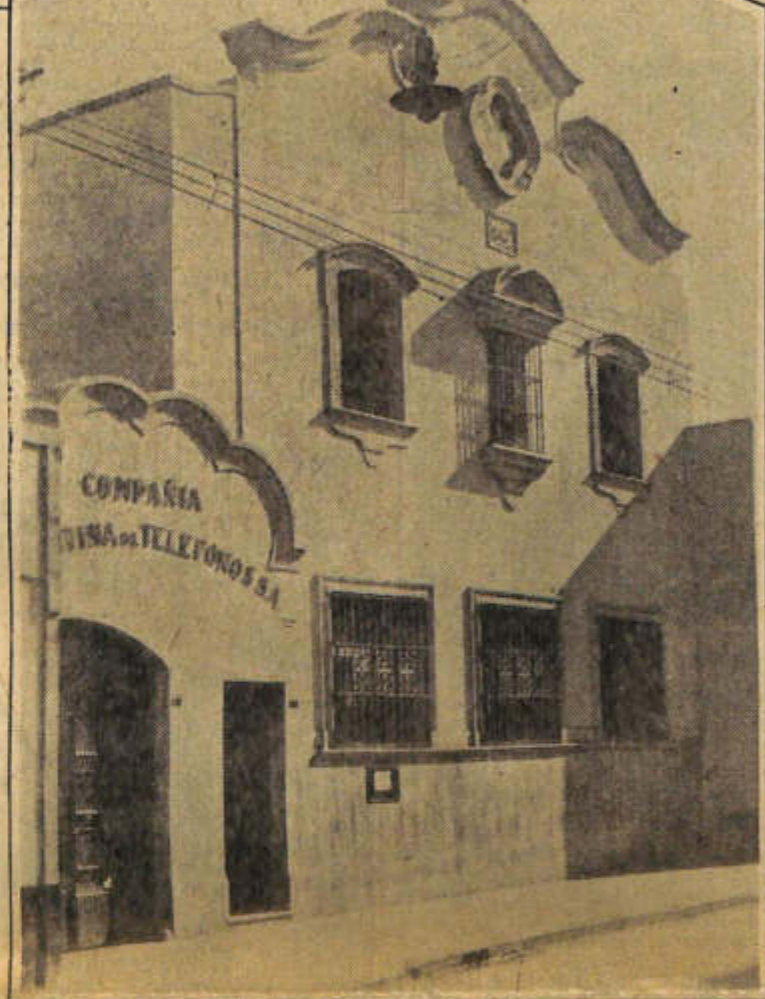
El edificio de la Compañía Argentina de Teléfonos de San Juan, que los nuevos movimientos sísmicos amenazan destruir totalmente
