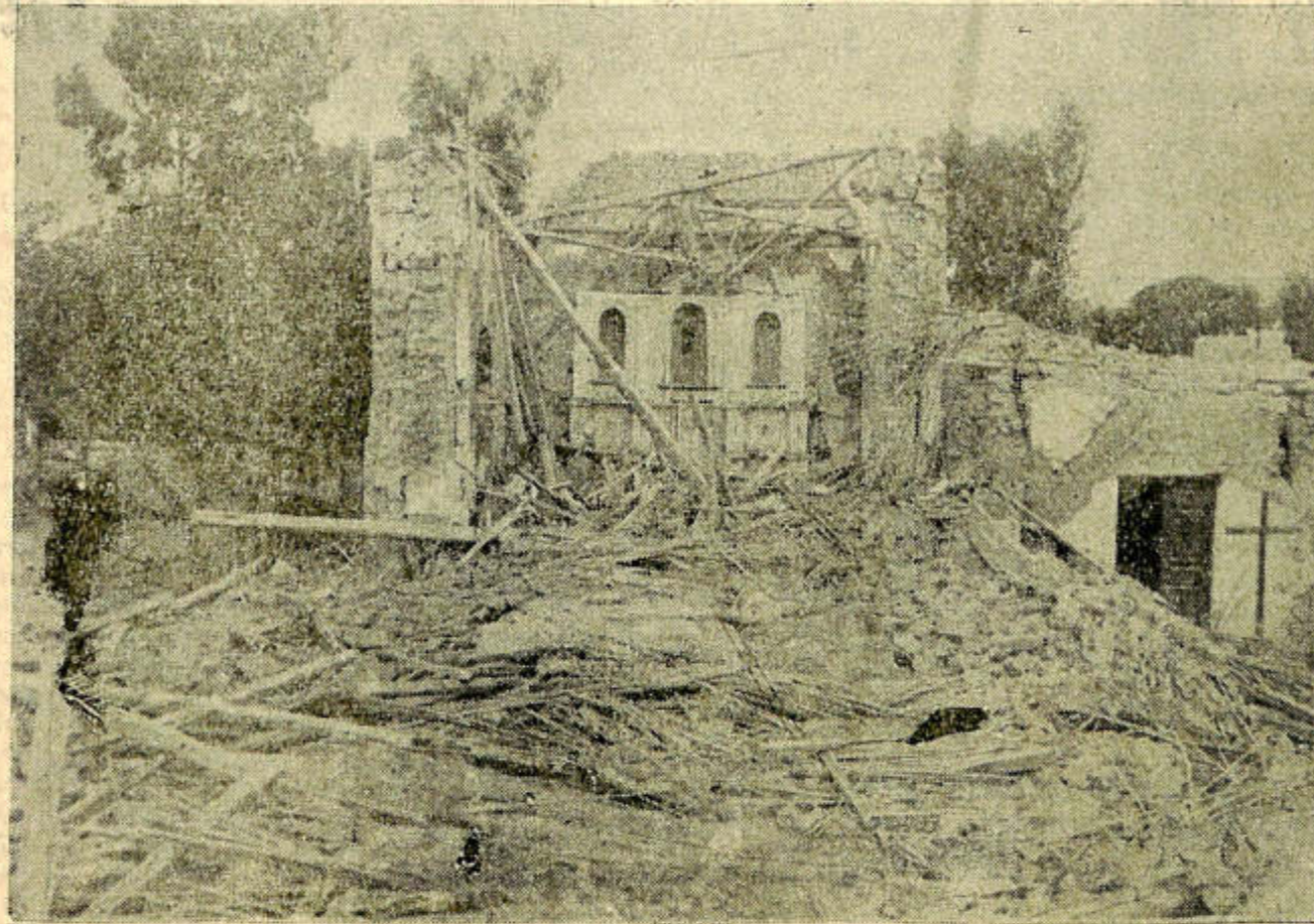
Restos de lo que fué la iglesia parroquial de Albardón, departamento en donde el sismo del 15 de enero se sintió con más violencia. Las pérdidas materiales, por edificación, en ese departamento como en una extensa zona del barrio de Concepción, fueron totales.
