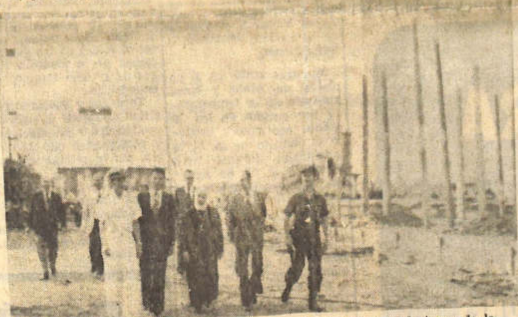
En torno a las autoridades que recorrieron las futuras instalaciones de la fábrica de galletitas, puede observarse una parte de la obra en construcción.
