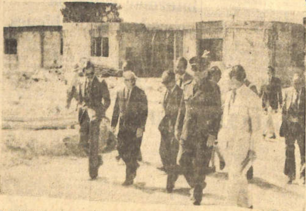
EL GOBERNADOR y Vázquez Llona, con el ministro de Economía, ingeniero Luis María Aróstegui y funcionarios del I.P.V., observan los trabajos de construcción del barrio "General Las Heras".
