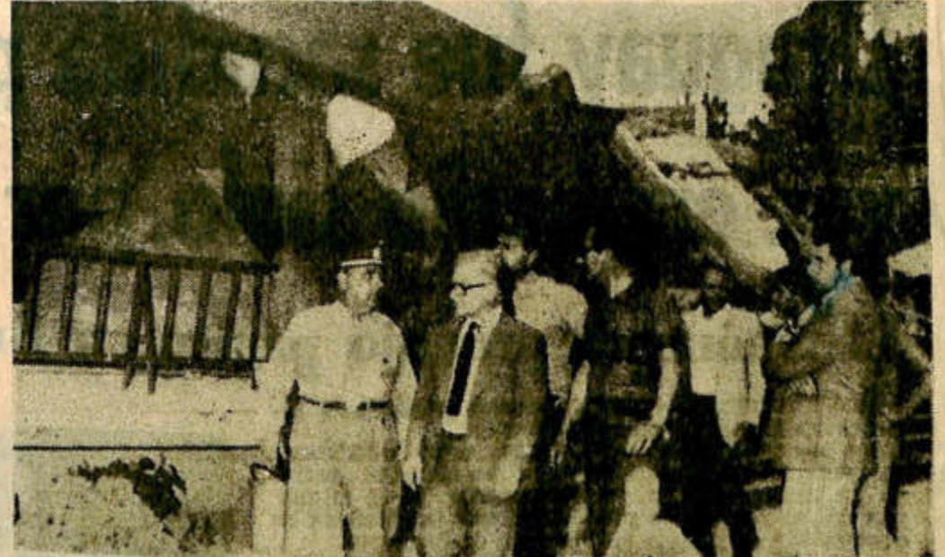
El coronel Menvielle, el ministro Aróstegui, tras ellos el gobernador de la provincia y el intendente de Cauce, durante la visita a la zona del desastre. Al fondo se ven las gruesas vigas quebradas del edificio de la Normal.
