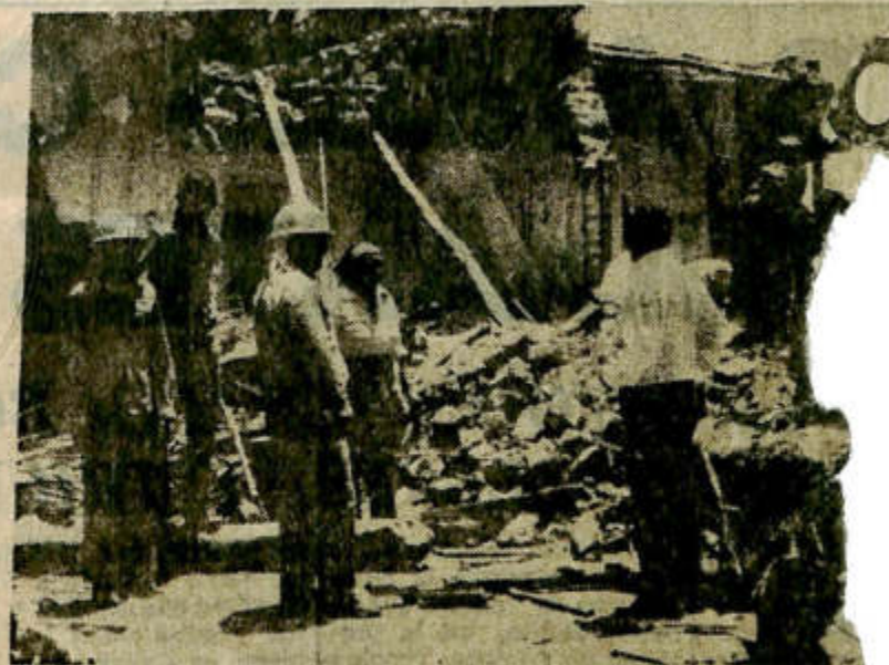
Aquí, en Los Berros, Sarmiento, se levantaban cinco casas que fueron totalmente destruidas. Sus propietarios se salvaron "milagrosamente" ya que todos, por sus ocupaciones cotidianas, estaban en el momento del terremoto.
