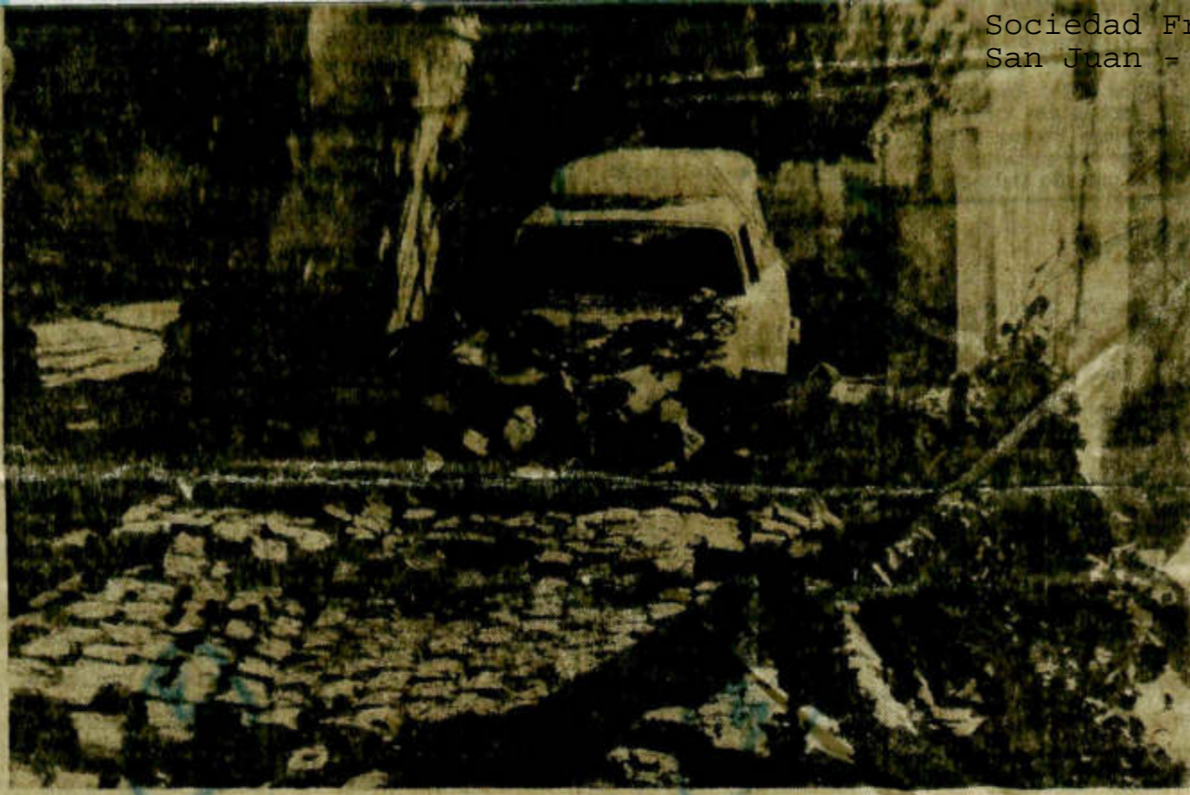
En Albardón, una pesada medianera de adobes cayó parcialmente, salvándose del aplastamiento total el vehículo que se ve en la fotografía.
