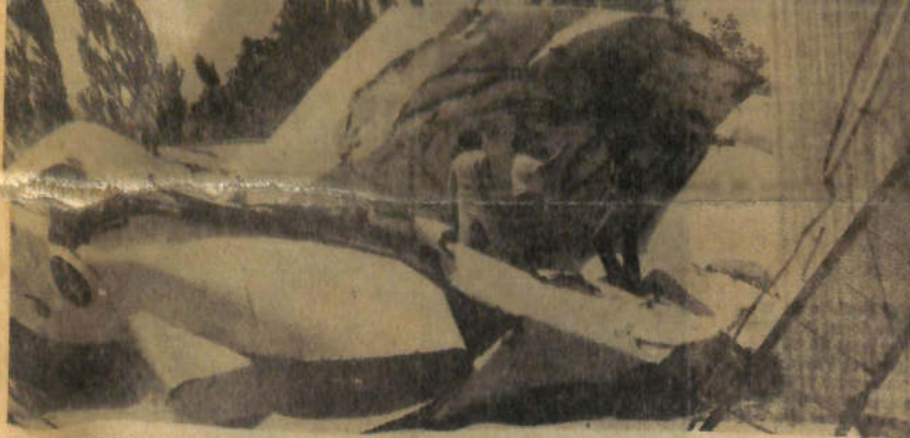
ASI QUEDO UNO DE LOS TANQUES metálicos de la bodega de José Bórbore, en San Martín. Los hierros quedaron retorcidos, se perdió todo el vino, y las pérdidas fueron cuantiosas. Otro tanto ocurrió en el resto de las bodegas de ese departamento.
