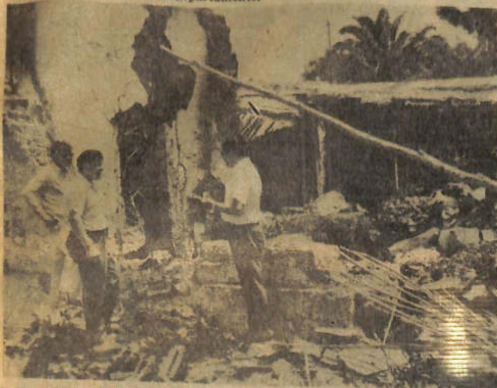
AQUI SE LEVANTABA un provisto almacén de propiedad de don Luis Castro. A los efectos del terremoto, que derrumbó el edificio, debió sumarse un incendio que destruyó todos los muebles y mercaderías existentes..
