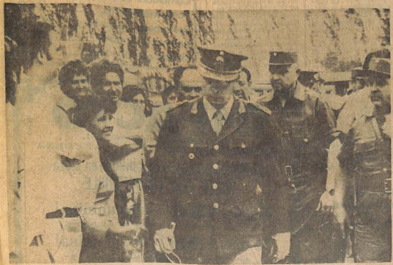
Numeroso público saludó al general Menéndez cuando ingresó a la Escuela Normal de Caucete, para verificar las ruinas en que quedó el edificio. Formuló preguntas e hizo observaciones.
