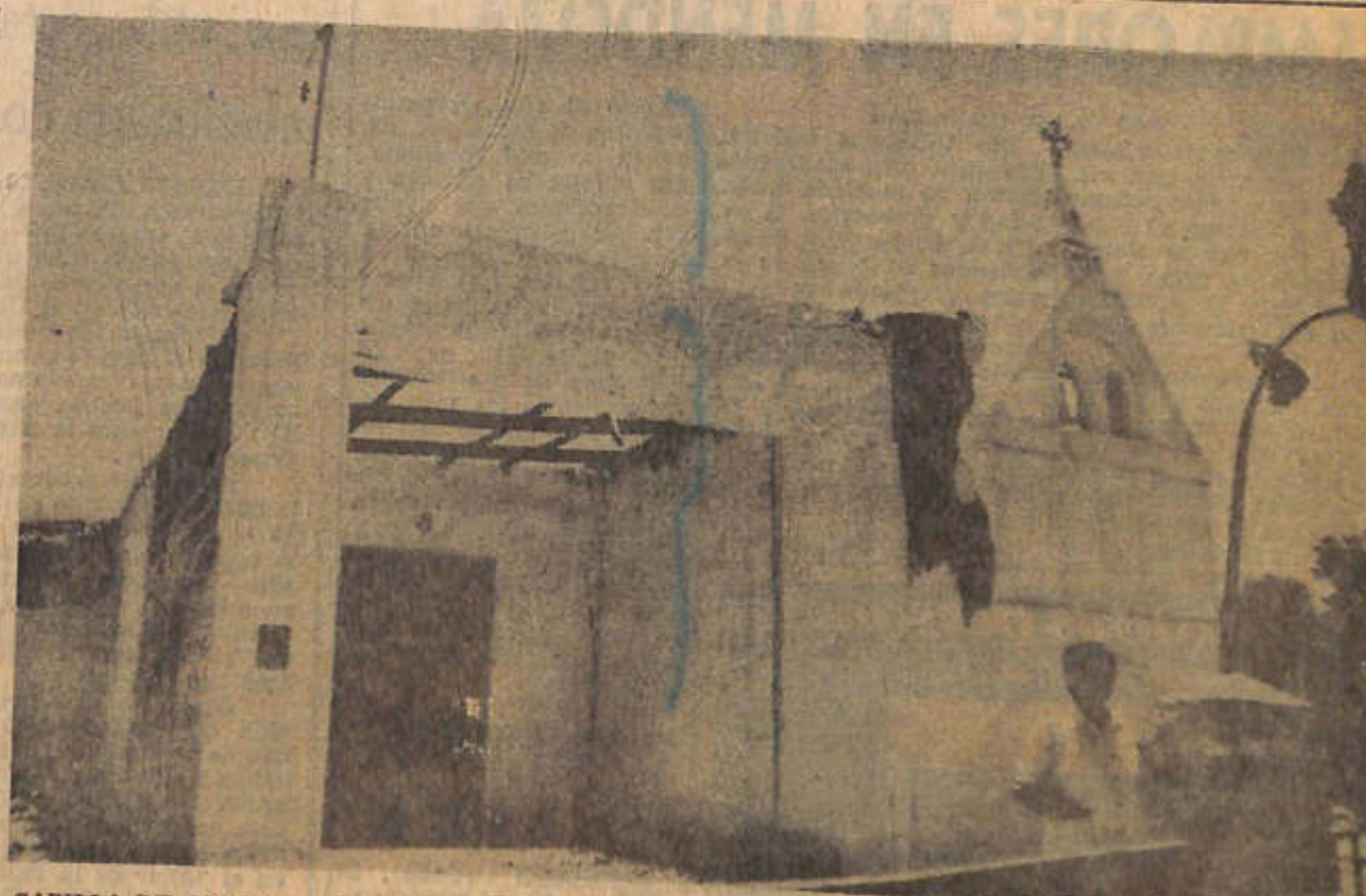
CAPILLA DE ASTICA. Uno de los edificios que sufrieron daños el pasado miércoles, como la mayoría de las construcciones. Pero la escuela nacional N° 35 sirve de albergue a más de 70 personas.
