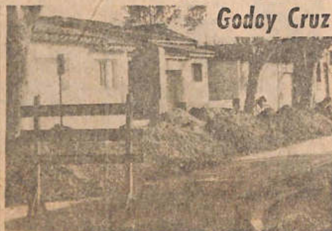
Los trabajos que se realizan en Villa Monasterio.
