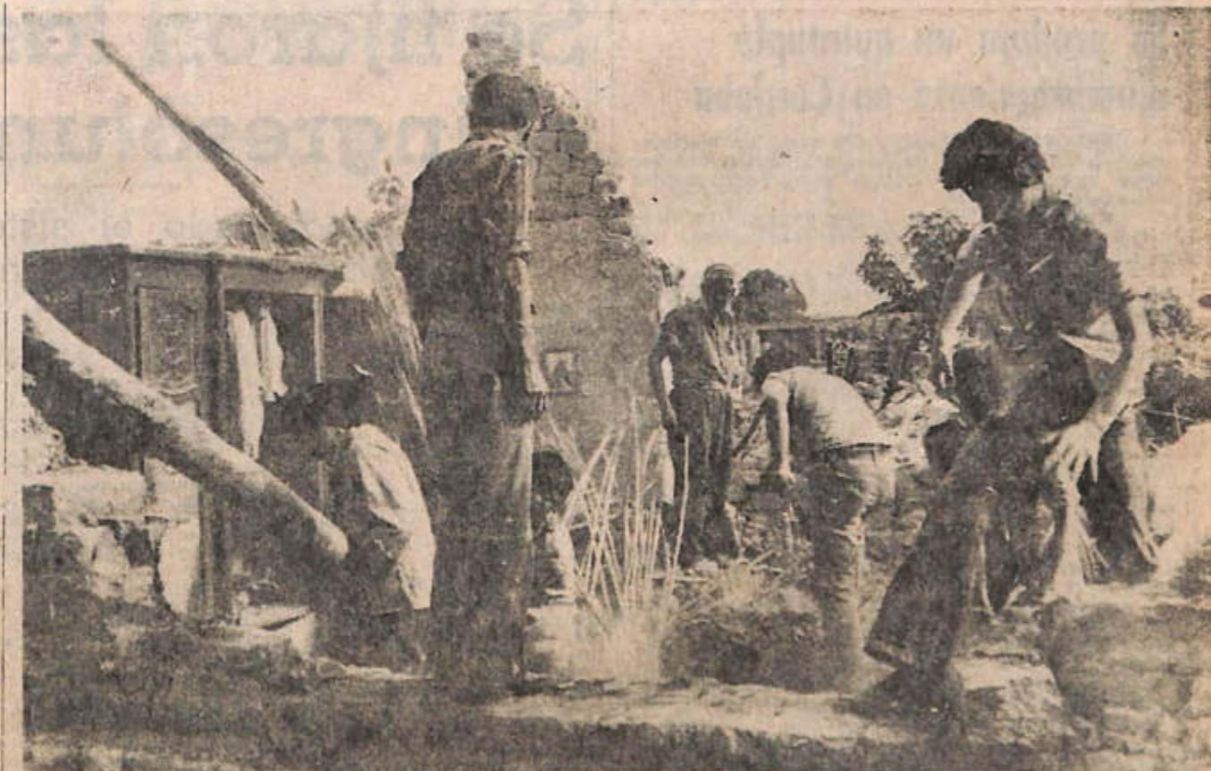
Las tareas de remoción de escombros y de definitiva demolición continúan a ritmo intenso.
