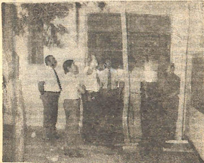
La escuela Carlos Pellegrini, sufrió los efectos del sismo, pero ya ha sido reparada. Todos los establecimientos educativos de Santa Lucía estarán en condiciones.
