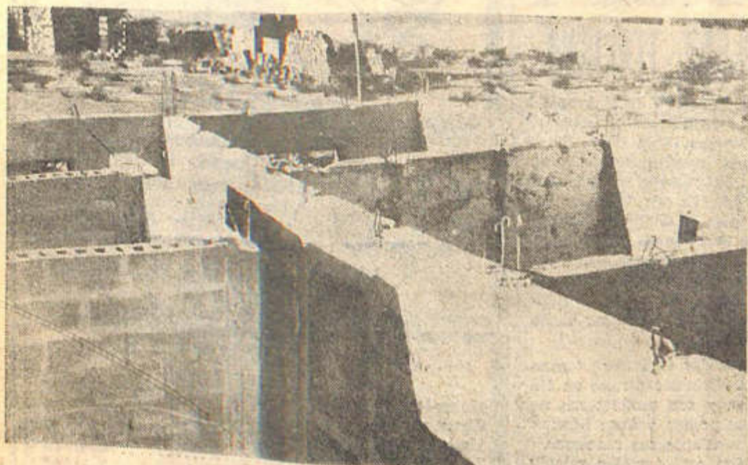
Vista general de una de las cinco casas hechas por el plan "Método constructivo, Viviendas Económicas", en su faz inicial. Se aprecian con claridad los muros sellados en paneles con un espesor de veinte centímetros.
