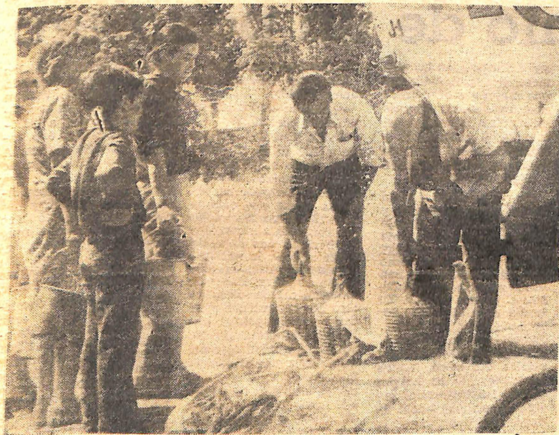
ABASTECIMIENTO de agua en Caucete. Se cumple a cargo de personal afectado a las tareas de salvataje. Este trabajo es impropio y se hace en forma continua.
