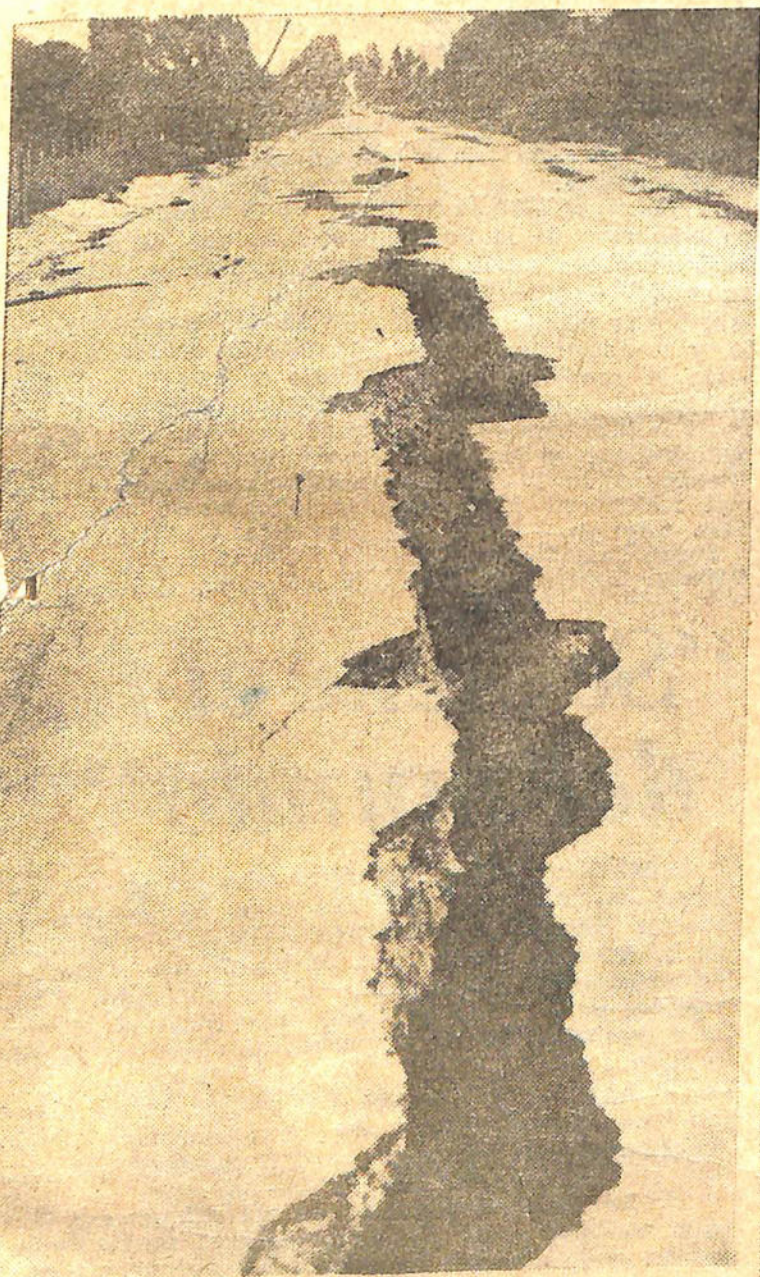
La calle La Plata, que une a los departamentos Caucete, 9 de Julio y 25 de Mayo, quedó intransitable después del sismo de esta mañana. La grieta, que tiene una longitud de aproximadamente 200 metros, se
