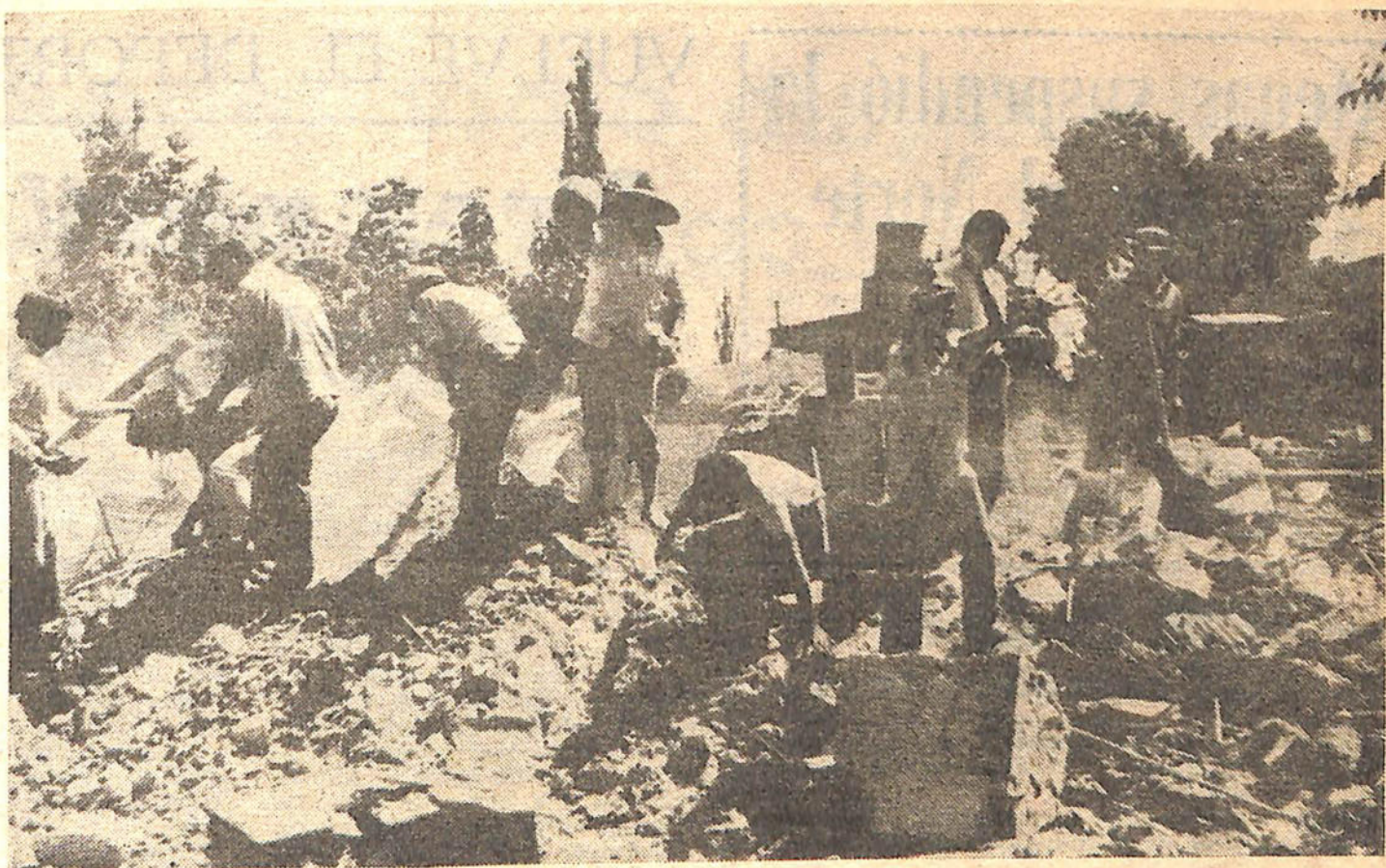
Los pobladores con el apoyo de máquinas y personal de municipios y otros entes oficiales, efectúan la remoción de escombros, retirar los elementos domésticos o materiales aprovechables y luego se carga el deshecho en camiones que lo llevan a las afueras de la ciudad de Caucete. Esta mañana todo era actividad.
