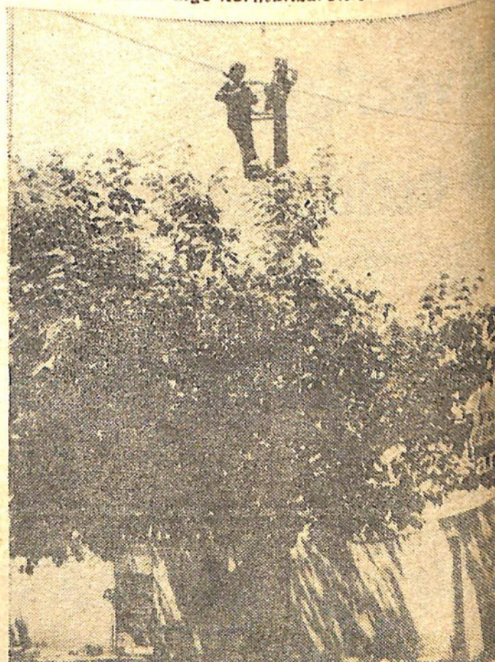
Un operario de la Compañía Argentina de Teléfonos, en lo alto de una columna, procede a poner en servicio parte de la red telefónica destruida por el terremoto.
