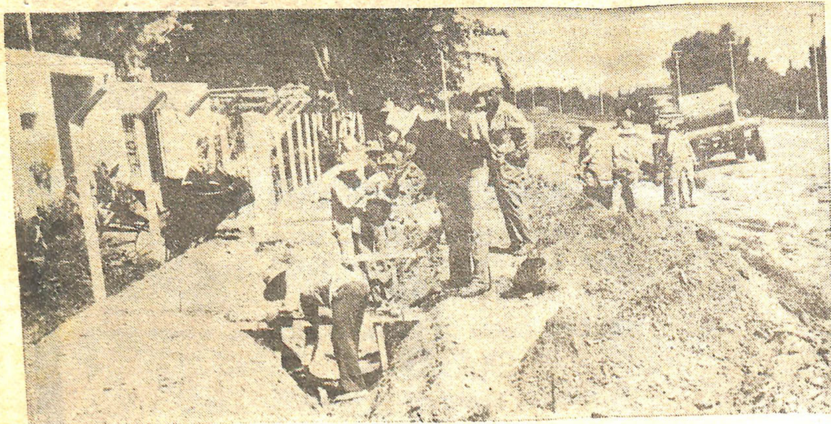
Personal del Departamento de Hidráulica, en Las Chacritas, 9 de Julio, procede a reconstruir un sector del canal impermeabilizado que lleva la agua de riego a esa zona y otras de Caucete. En otros puntos del área afectada por el terremoto del miércoles último, se procede con toda celeridad a reparar cauces.
