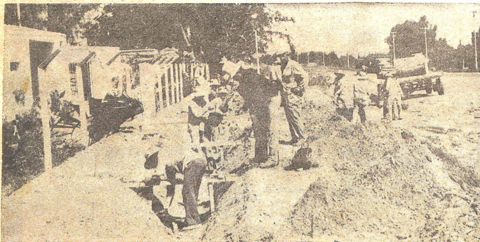
Personal del Departamento de Hidráulica, en Las Chacritas, 9 de Julio, procede a reconstruir un sector del canal impermeabilizado que lleva la agua de riego a esa zona y otras de Caucete. En otros puntos del área afectada por el terremoto del miércoles último, se procede con toda celeridad a reparar cauces.
